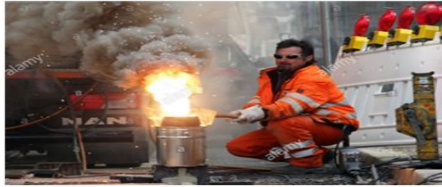
الصورة ١-٧ إصلاح خط سكة حديد باستخدام تفاعل الألومنيوم مع أكسيد الحديد (III)
