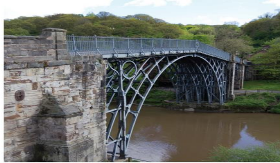
الصورة ٢-٣ الجسر المُشيد في منطقة أيروتريديج كان أول جسر على الإطلاق يتم تشييده من الحديد
